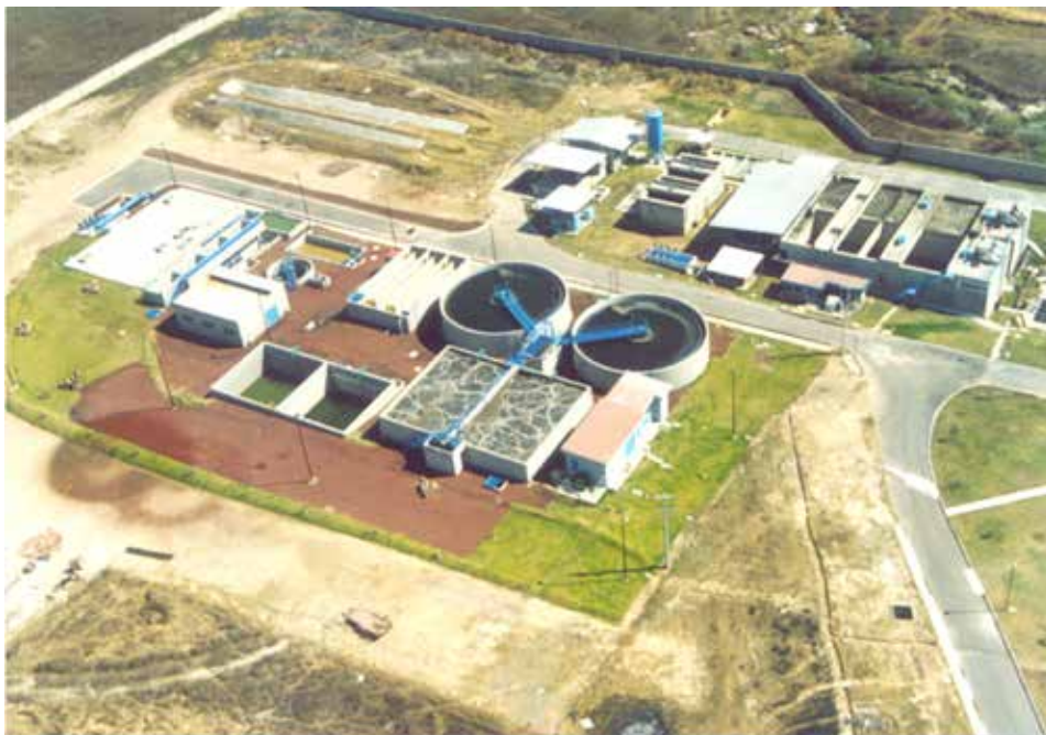
Figura. 7.31. Planta de tratamiento de aguas residuales río Blanco
