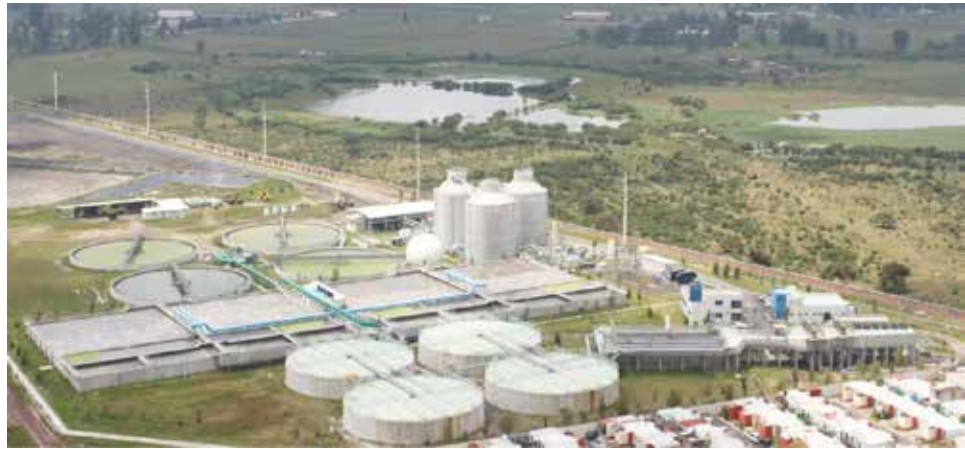
Figura. 7.29. Planta de tratamiento de aguas residuales El Ahogado
