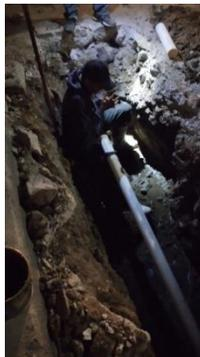
**Obras:** Conexión de Agua Potable 1,200 mts tubería 2" Zona Limón en San Nicolás.
