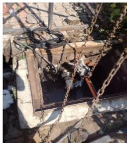
**Obras:** Sustitución de tubo obsoleto de línea de drenaje 58 mts. en Zaragoza de Batalla de Puebla hacia Pepe Guizar.
