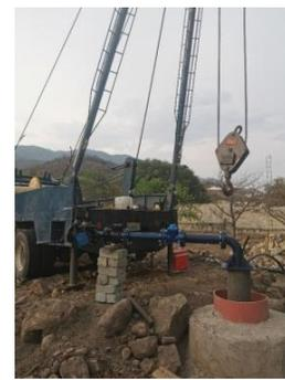
**Obras:** Extracción de bomba en Pozo # 4 en Ajjic, 11 de Febrero del 2022.
